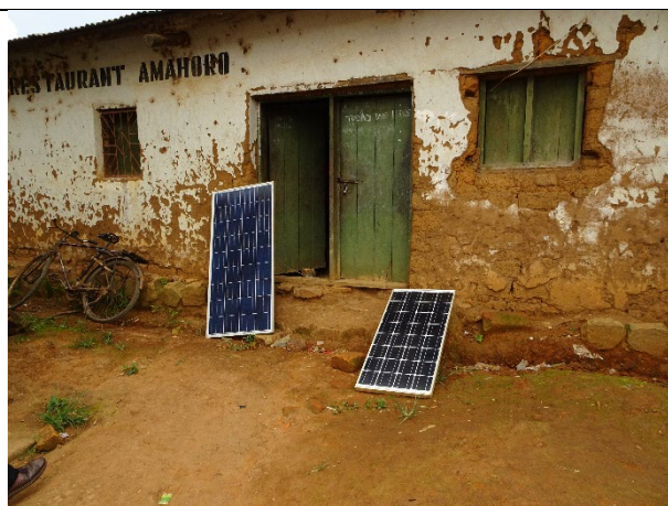
Photo 9: Panneaux solaires pour l'alimentation alternative de la salle de cinéma
