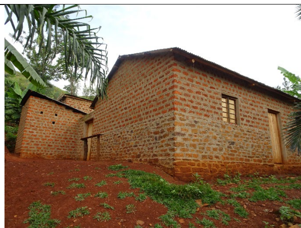
Photo 12: Maison en dure construite suite à l'appui du projet
