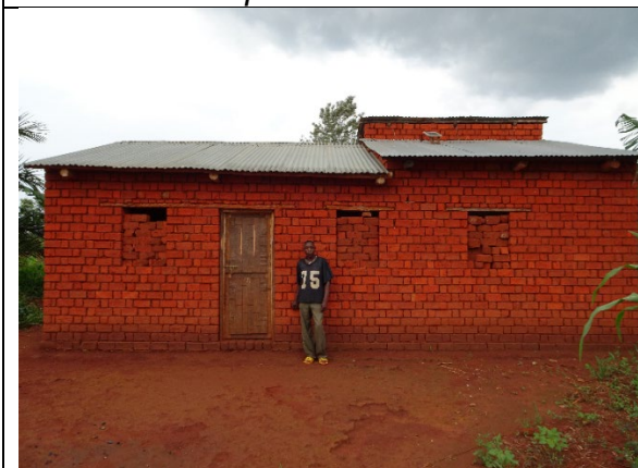
Photo 15: Nouvelle Habitation de NYANDWI Ernest en briques adobes et tôles (Coordonnées GPS : 3°40'9" S/30°18'0,6" E; Altitude : 1220 m)
